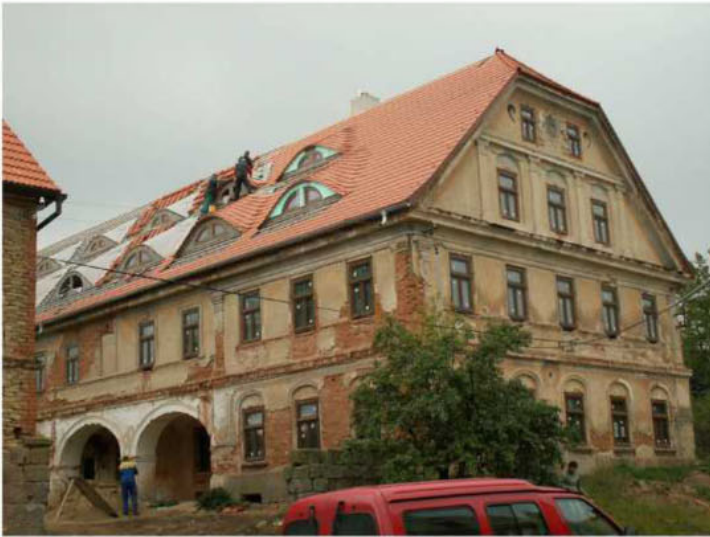
Montáž střešní krytiny a oken
