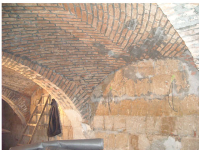
Opravy kleneb ve společenské místnosti
