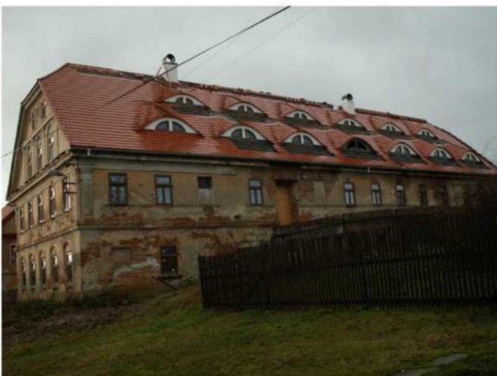
Montáž střešní krytiny a oken
