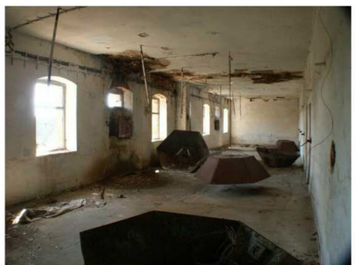
Hospodářská místnost - 2.NP
