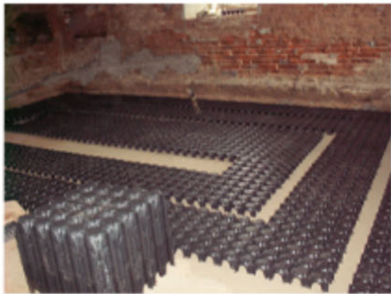
Odstranění vlhkosti odvětráním podlah
