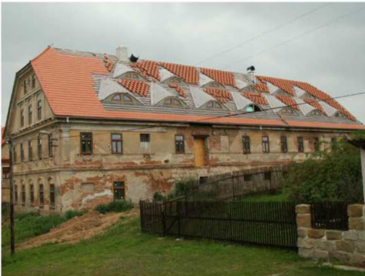
Montáž střešní krytiny a oken
