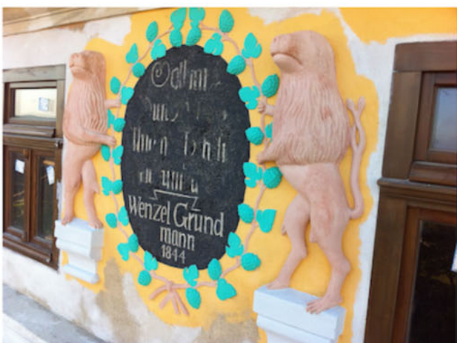
Obnovení domovního štítu
