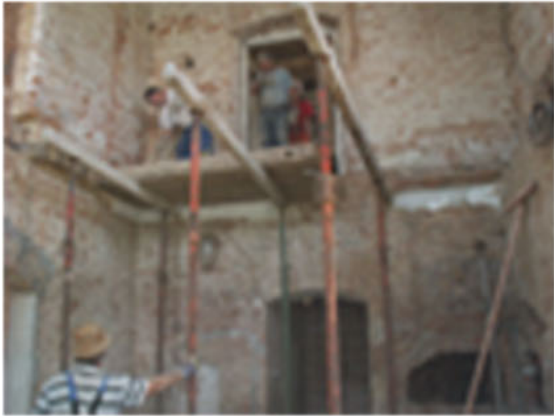
Výměna povalového stromu za trámový
