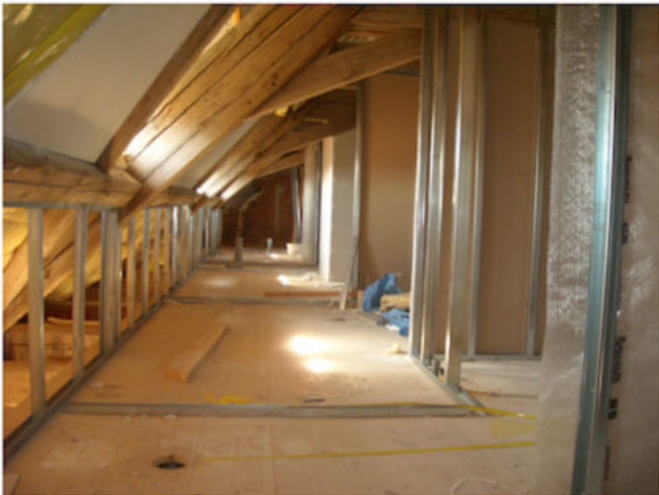
Opravy vnitřních prostor v podkroví
