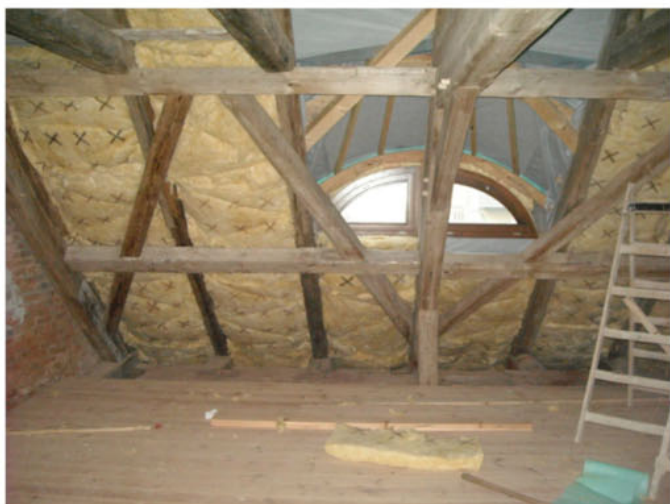
Zateplení a sádrokartonové konstrukce v podkroví
