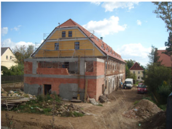
Oprava fasády a přístavba na západním štítu
