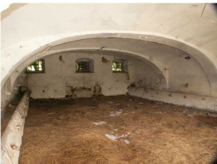
Hospodářské místnosti v 1. NP objektu
